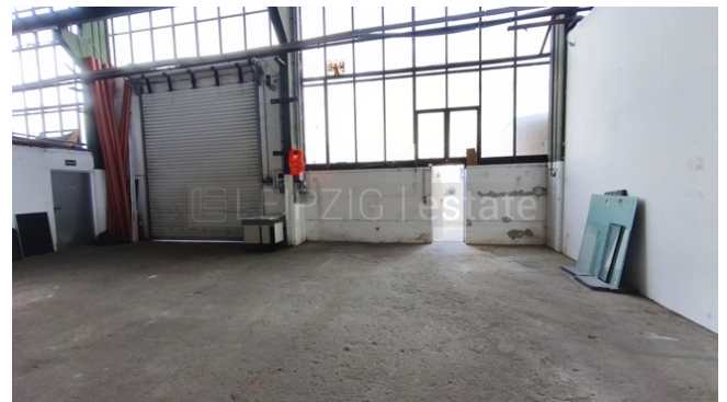
Rolltor und Eingangsbereich von innen
