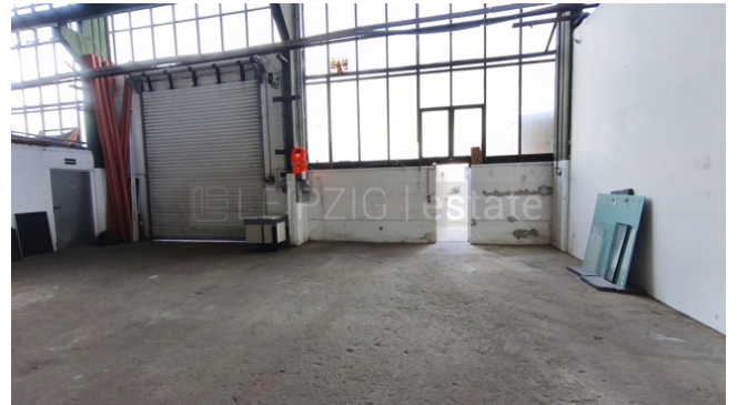
Rolltor und Eingangsbereich von innen
