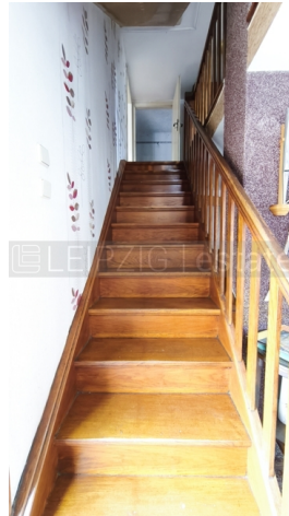
Treppe zum Obergeschoss
