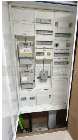
Hauptsicherungskasten
