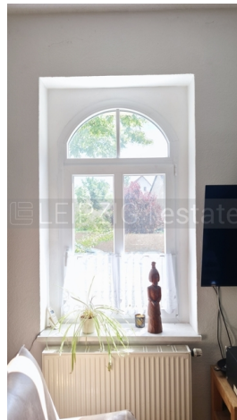
Rundbogenfenster im Erdgeschoss
