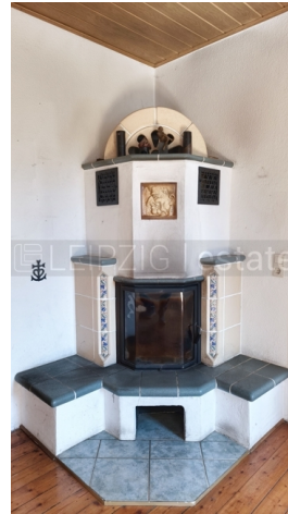
Kamin im Obergeschoss
