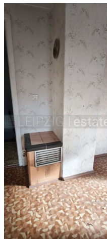
Kaminheizung im Kinderzimmer
