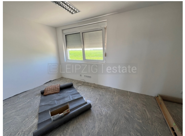
Büro 1 im Ausbau
