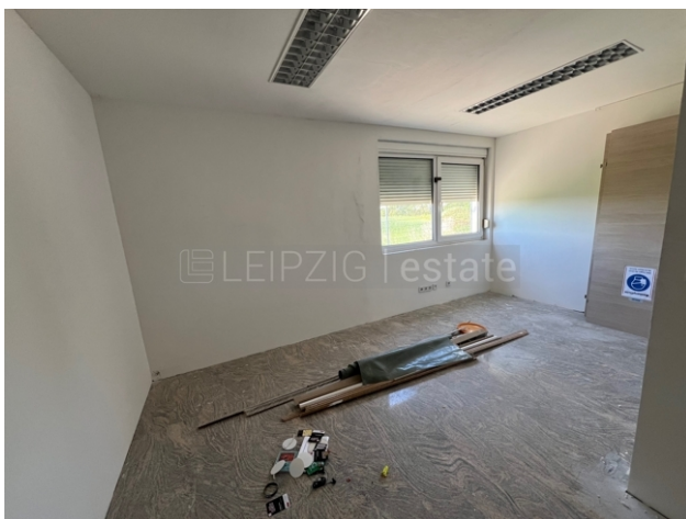
Büro 2 im Ausbau
